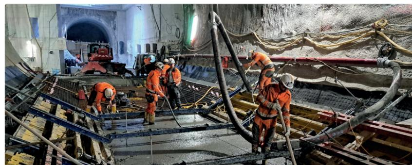
↑ Beim Ausbau der U2 wird eine Teil der Innenschale eines Notausstiegs mit Recyclingbeton und innovativer mineralischer Bewehrung hergestellt.
